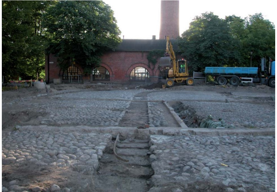
Kuva 13. Kustaa III:n aukiolla sijaitseva kenttäkiveys ja kapearaitaisen rautatien osia. Rakenteita peittää nykyisin tekonurmi. (Kalle Luoto)
